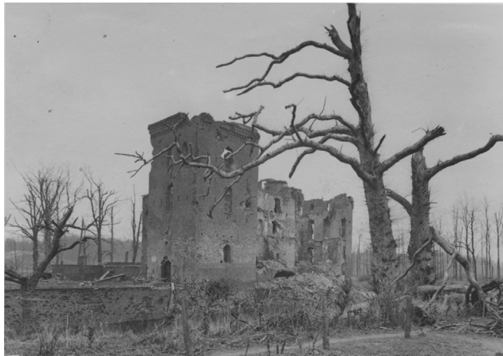
Kasteel Doorwerth liep grote schade op bij de Slag om Arnhem (foto Gelders Archief)
